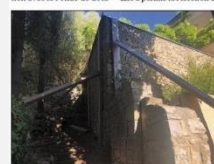
Consolidation à venir du mur de la grande terrasse.
